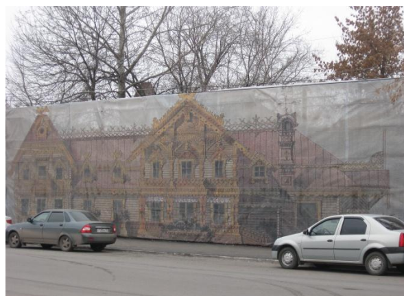
Рисунок 2 - На фото уже сгоревший дом затянут фальш-фасадом.
