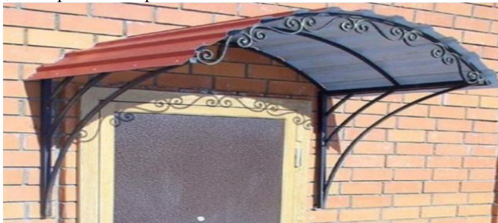
Рисунок 7 - Козырек из металла
