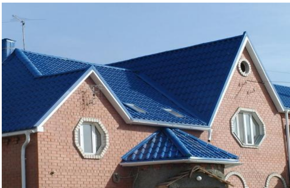
Рисунок 10 - Козырек из металлочерепицы
