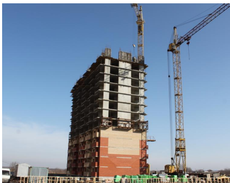
Рисунок 3 – Несущий остов жилого дома с наружными кирпичными стенами
