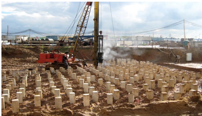
Рисунок 1 – Забивка свай
