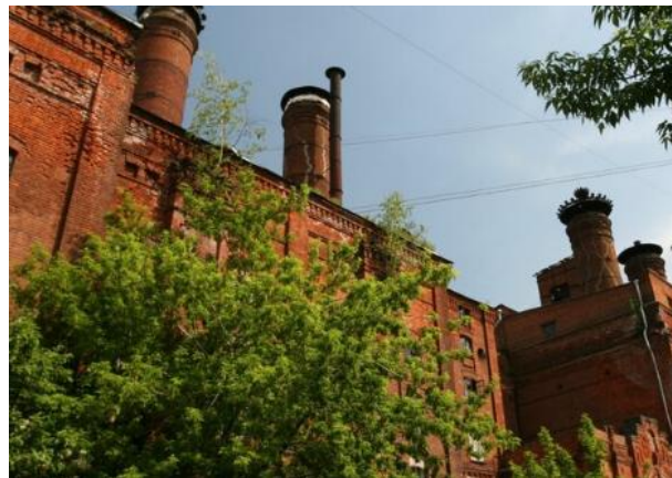
Рисунок 4 - Главный корпус Бадаевского завода. 1890 год постройки
