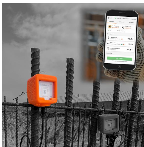
Рисунок 3 – Умный датчик на арматуре
