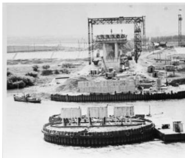
Рисунок 2 – Строительство Окского моста
