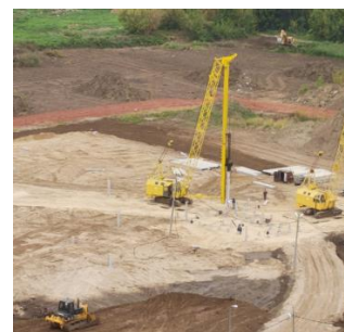
Рисунок 4 – Завивка свайного поля под здание школы
