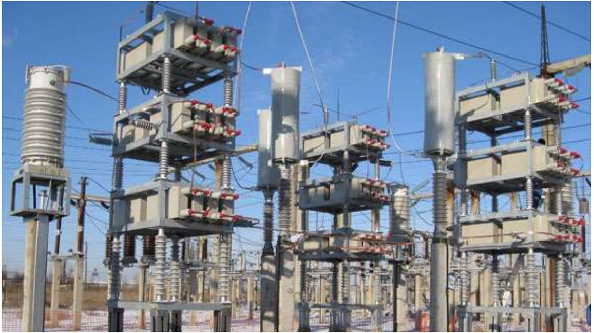
Рисунок 1 - Внешний вид батареи статических конденсаторов
