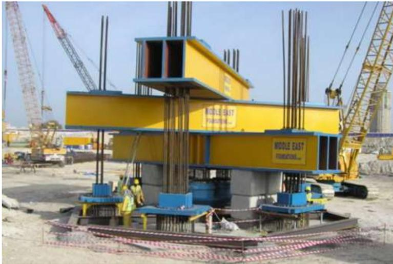
Рисунок 3 - Испытание сваи на статическую нагрузку
